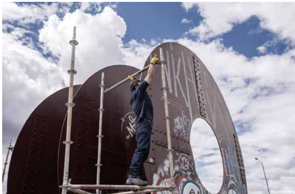
PROCESO DE MONTAJE PARA LA PROTECCIÓN TEMPORAL DE LA OBRA ECLIPSE
